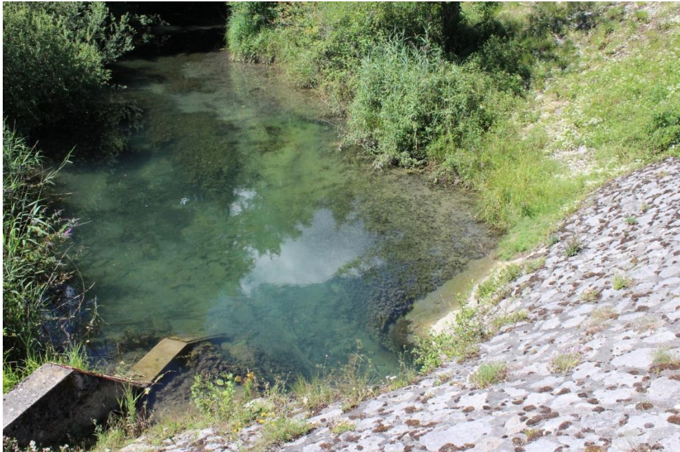
Figure 6. Vue de la tête aval de la buse se rejetant dans le Jourdan avant le passage sous la RD 992 - (ACME -2021)
