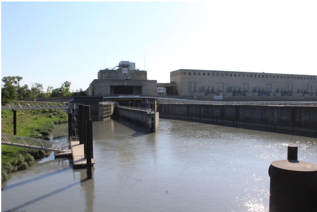
Figure 15. Vue sur le garage aval de l'écluse de Châteauneuf-du-Rhône (CNR 2019)
