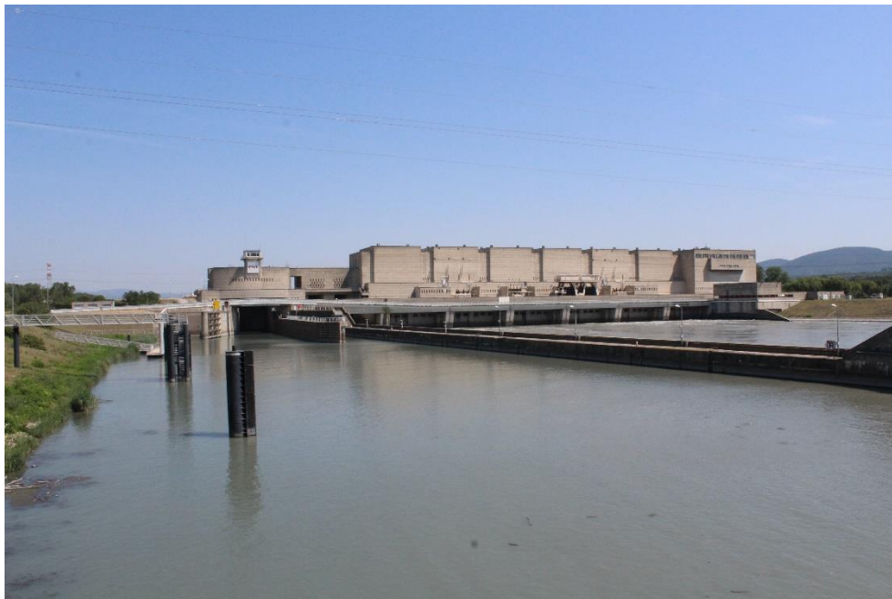
Figure 12. Vue du garage aval de l'écluse de Logis-Neuf depuis l'amont (ACME, 2019)
