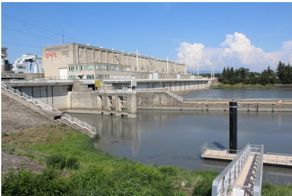
Figure 13. Vue du garage aval de l'écluse de Beauchastel (CNR, 2019)
