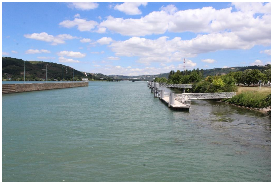
Figure 7. Le garage amont de l'écluse de Vaugris (ACM 2020)
