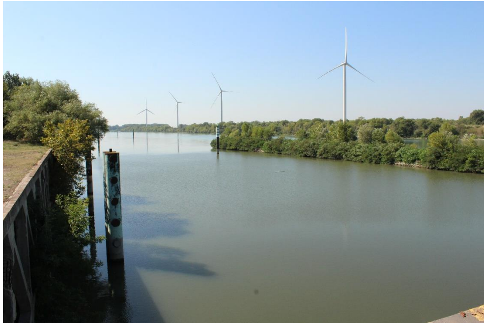
Figure 13. Vue du quai de Tarascon vers l'aval (ACME 2018)
