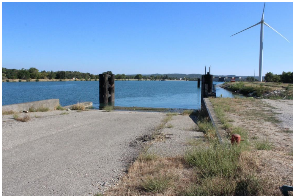
Figure 7. Vue du quai poste RORO, en direction de l'usine de Bollène (ACME, 2019)
