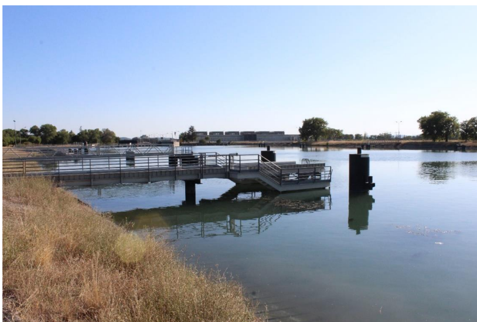
Figure 9. Vue du garage amont de l'écluse de Bollène vers l'amont (ACME, 2019)
