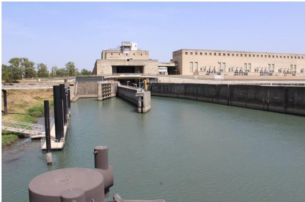
Figure 15. Vue sur le garage aval de l'écluse de Châteauneuf-du-Rhône (ACM 2018)
