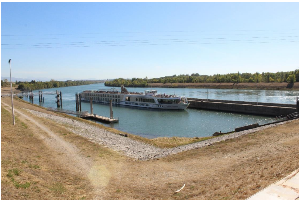
Figure 11. Vue amont du garage aval de l'écluse de Bourg-lès-Valence (ACME -2018).
