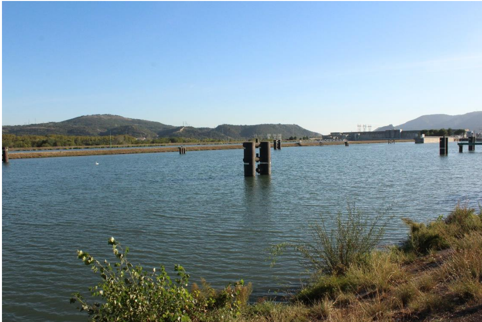
Figure 15. Ducs d'Albes du garage amont de l'écluse de Châteauneuf-du-Rhône (ACME, 2018)
