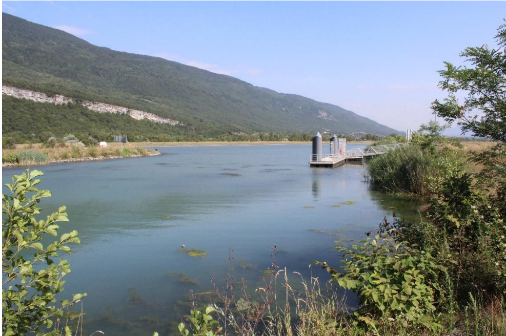
Figure 16. Garage amont de l'écluse amont de Chautagne (ACME, 2019)
