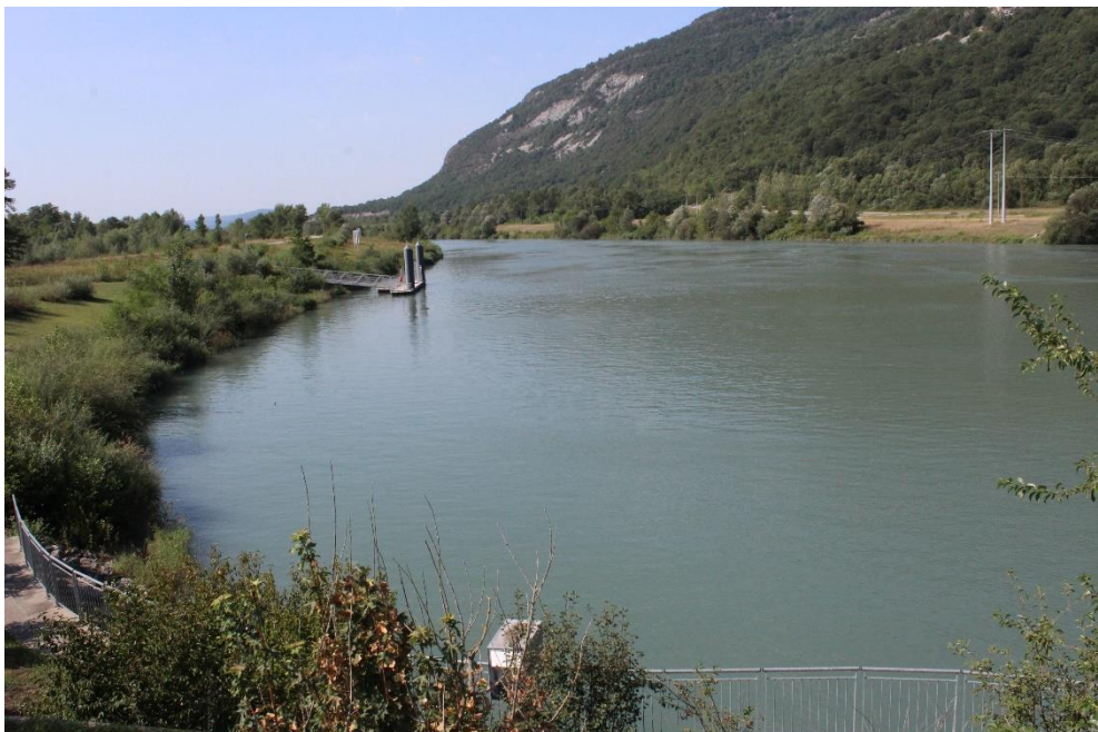
Figure 17. Garage aval de l'écluse aval de Chautagne (ACME, 2019)
