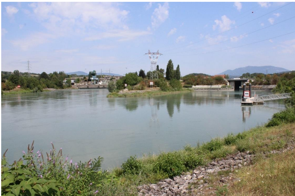
Figure 18. Garage aval de l'écluse aval de Belley (ACME, 2019)
