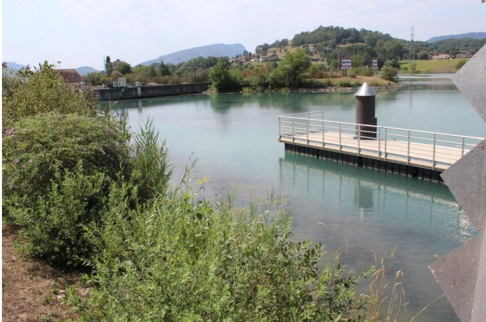
Figure 17. Garage amont de l'écluse amont de Belley (ACME, 2019)
