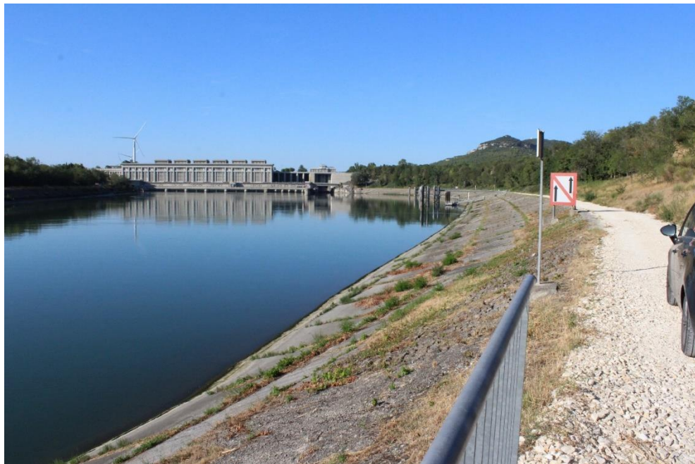
Figure 9. Vue du garage aval de l'écluse de Bollène vers l'aval (ACME, 2019)
