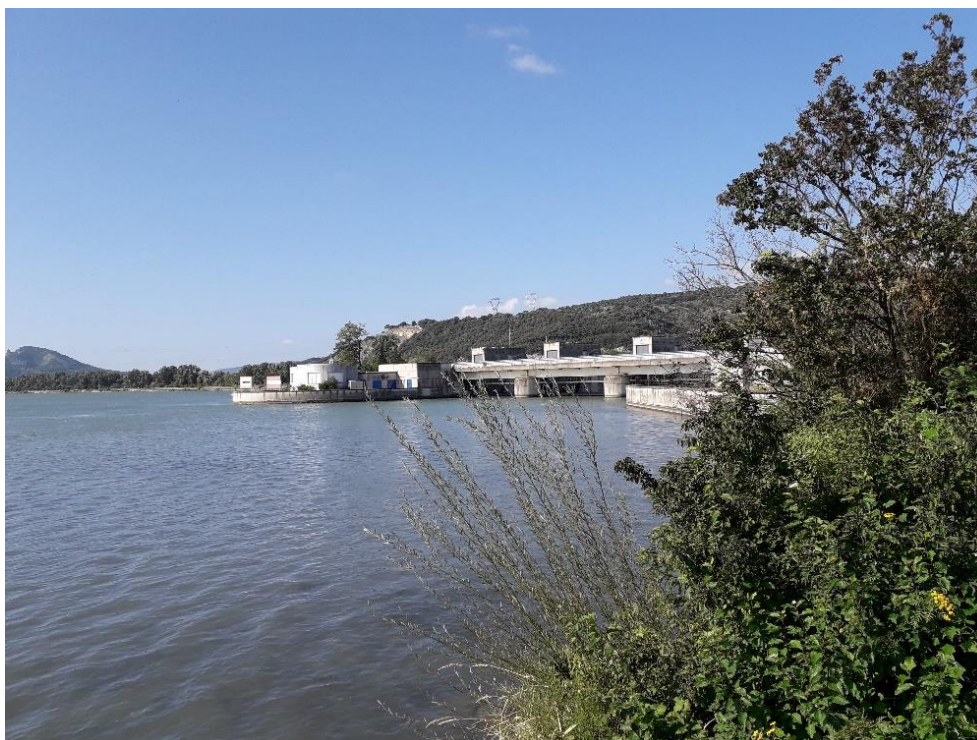
Figure 8. Vue du barrage de l'Isère depuis l'amont (ARTELIA, 2021)
