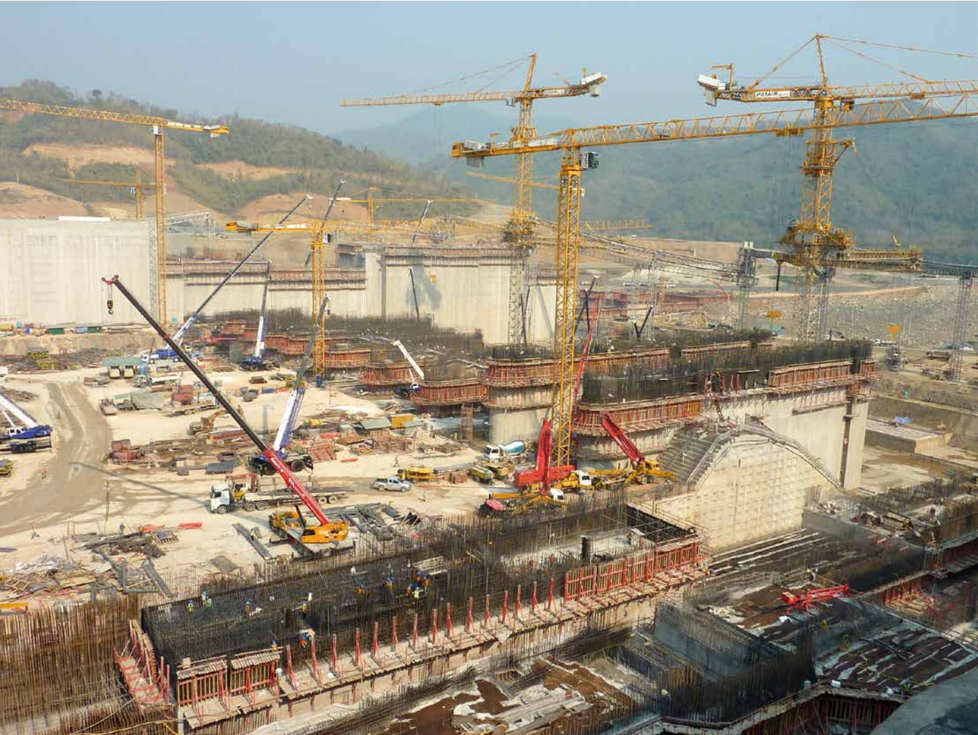
Barrage de Xayaburi en construction
