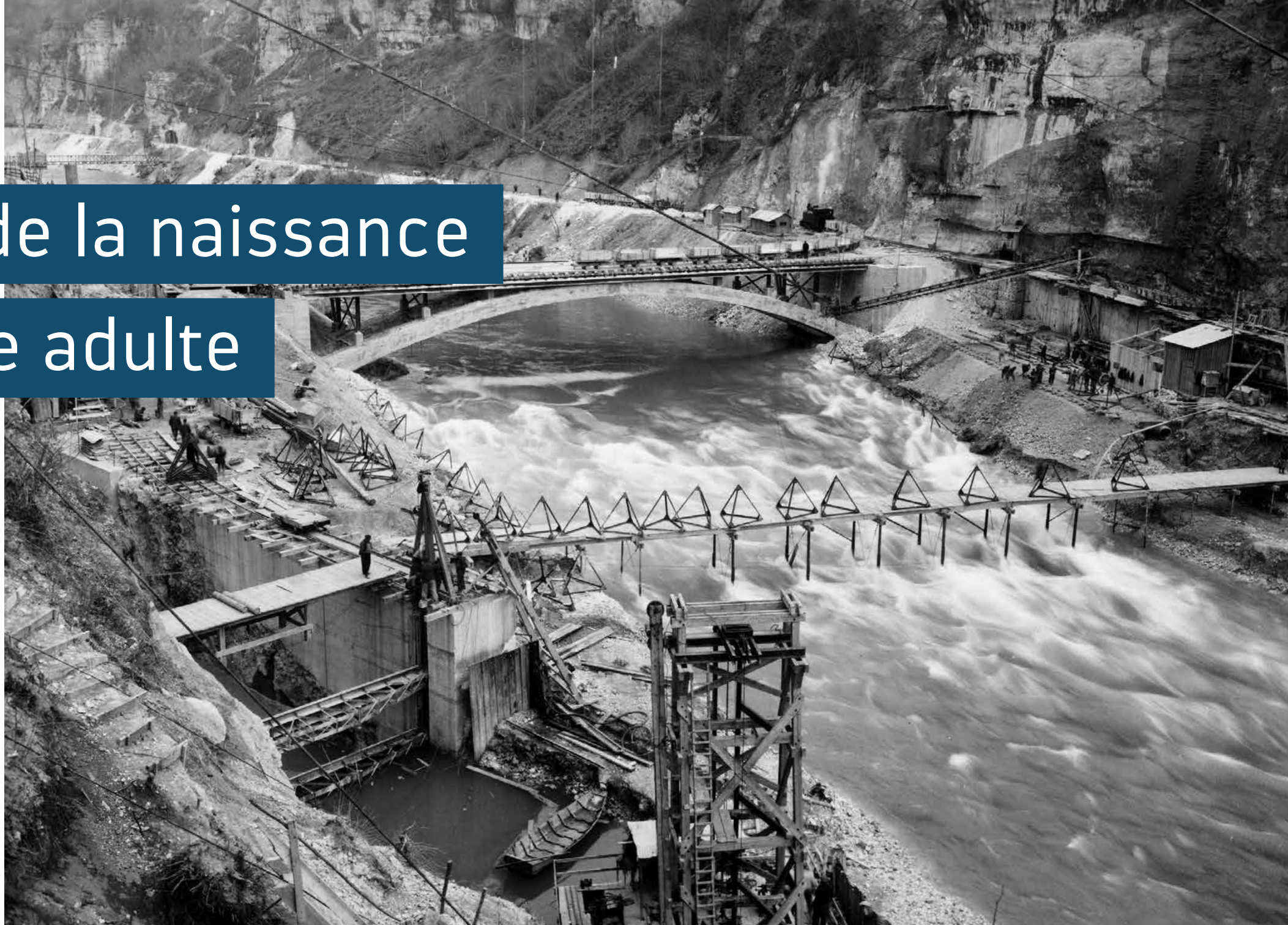
Barrage de Génissiat en construction
