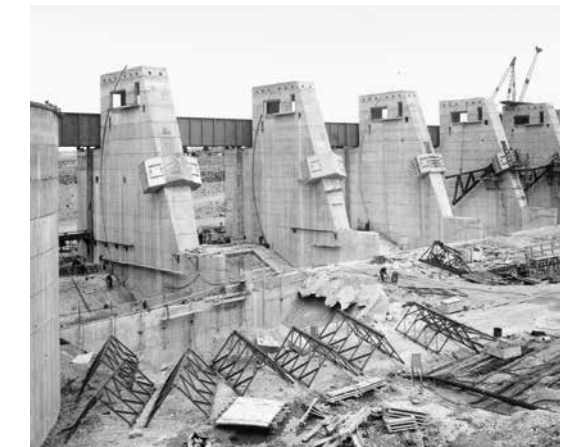
Barrage de la Roche de Glun en construction
