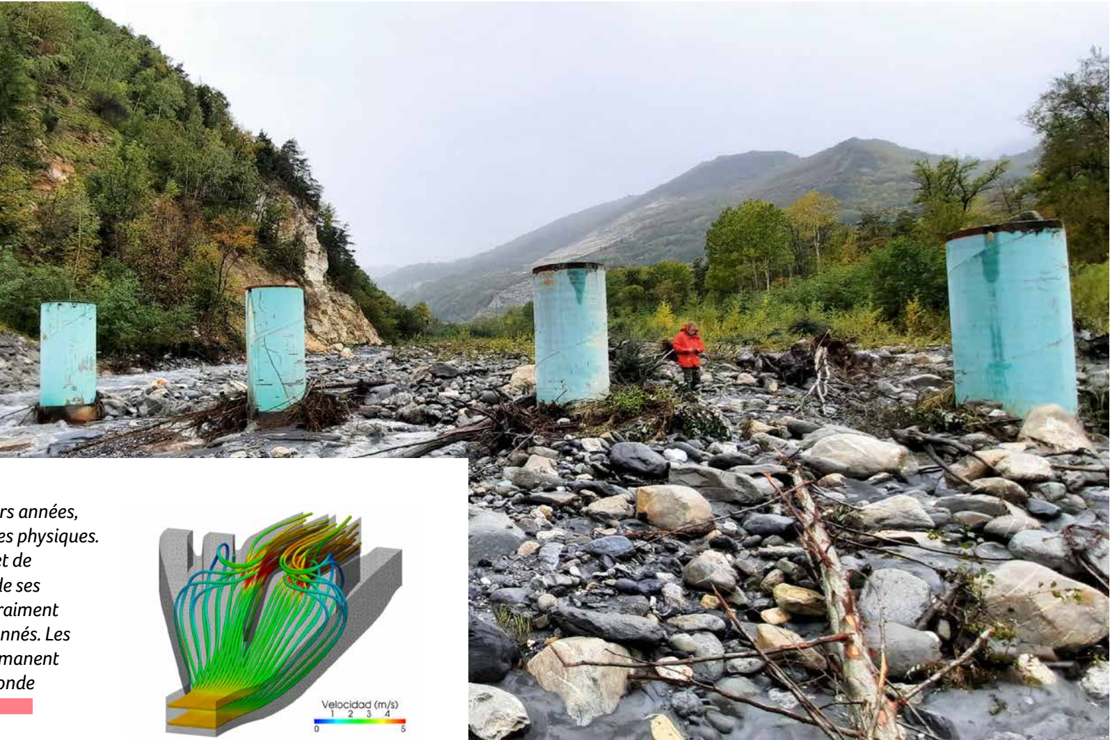
Piège à flottants de l’Arvan après réalisation
