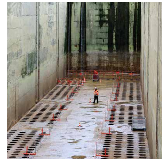
Inspection d'un sas d'écluse
