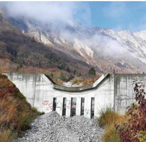
Plage de dépôt du torrent du Manival
