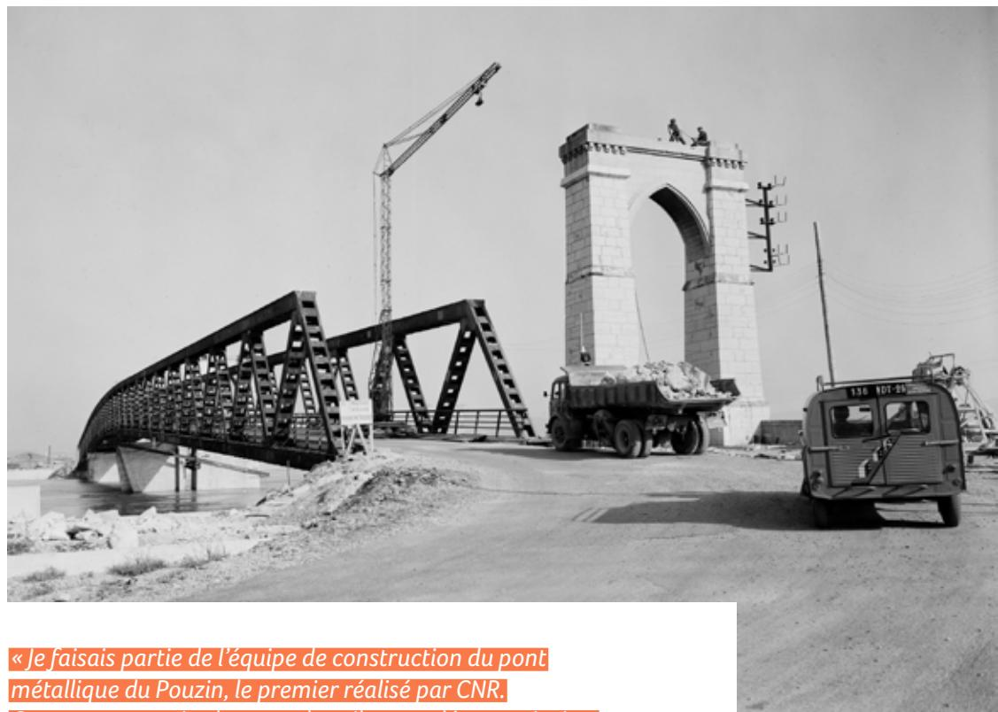
**« Je faisais partie de l'équipe de construction du pont métallique du Pouzin, le premier réalisé par CNR. Cet ouvrage a pris place sur des piles et culées provisoires en béton, en amont du pont suspendu de l'époque. Ce dernier a été détruit, sauf ses piles et culées qui ont reçu le nouveau tablier par ripage sans interruption de la navigation. »**
