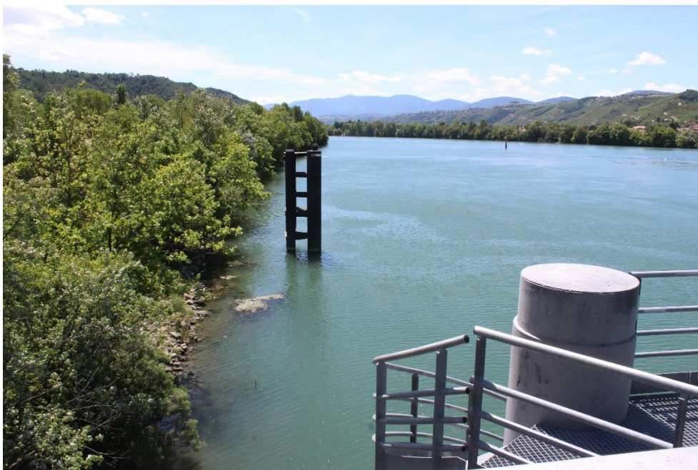
Figure 8. Le garage aval de l'écluse de Vaugris (ACM 2020)
