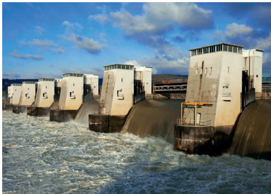
Le barrage du Pouzin, sur le Rhône (07).
