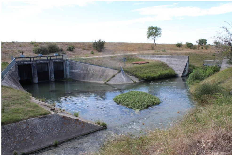
Figure 2. Bassin amont du siphon de la Gaffière (ACME – 2020)
