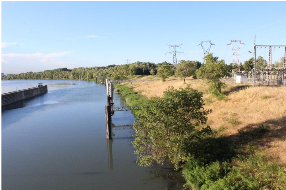
Figure 8. Vue vers l'aval du garage aval de l'écluse de Caderousse (ACME, 2020)
