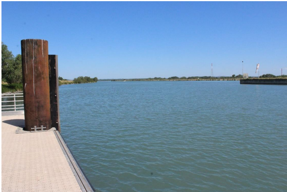
Figure 8. Vue du garage amont de l'écluse de Beaucaire (ACME, 2020)
