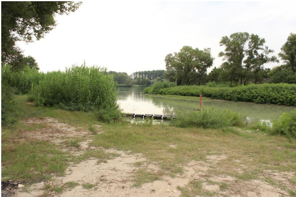
Figure 11. Vue de l'entonnement de la vanne de l'Aygues (ACME 2018)
