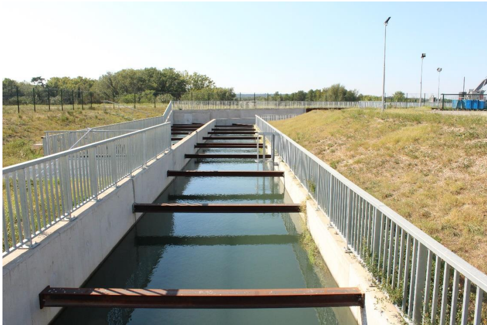
Figure 12. Vue, vers l'amont, du canal d'aménée de la passe à poissons de Sauveterre (ACME,2018)
