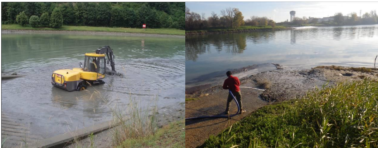
Figure 2 : Exemple d'opérations de dragage de rampes à bateaux avec une pelle terrestre ou une motopompe.
