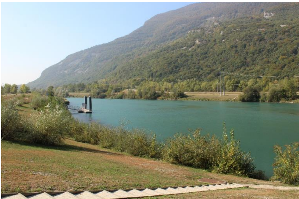
Figure 14. Garage aval de l'écluse aval de Chautagne (ACME 2018)
