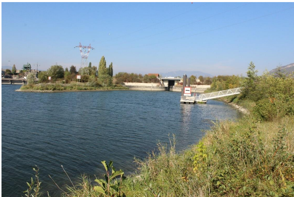
Figure 15. Garage aval de l'écluse aval de Belley (ACME, 2018)
