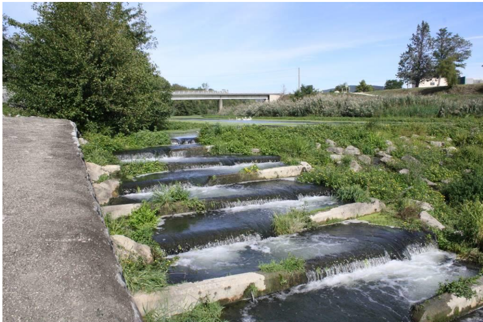
Figure 2. Aménagement piscicole du seuil du Laveyzon – CNR 2012
