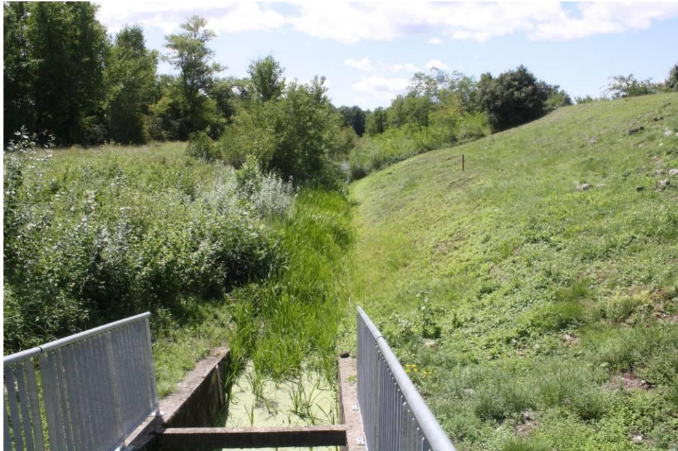
Figure 10: Vue du contre-canal depuis l'amont (ACME 2014)
