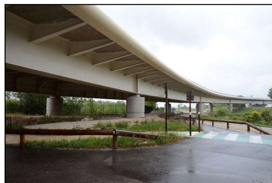
Figure 73 : Pont N1007 (Avignon)
