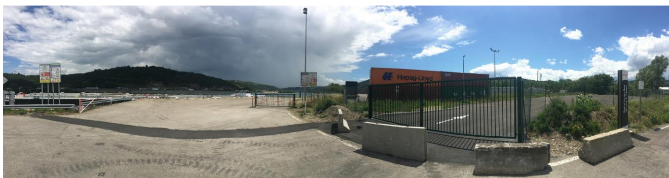
L'arrière-quai (ici à droite du cliché) de 2 500 m 2 , viendra en complément du quai.
