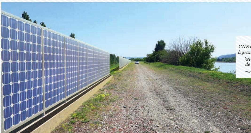
*CNR anticipe un déploiement à grande échelle de ce nouveau type de centrale équipée de panneaux bifaciaux.*
