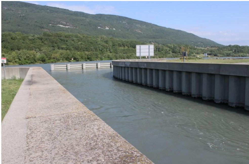
Figure 14. Canal d'aménée de la PCH de Motz – vue vers l'amont (ACME 2019)
