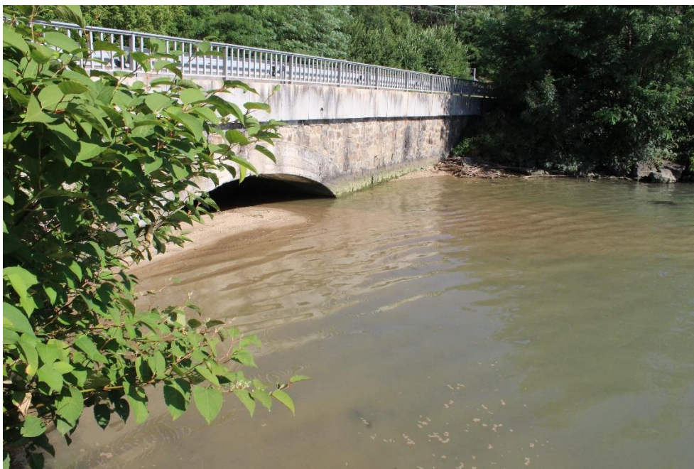
Figure 14. La confluence du Riverolles en aval du pont de la RN7 (ACME - 2019)
