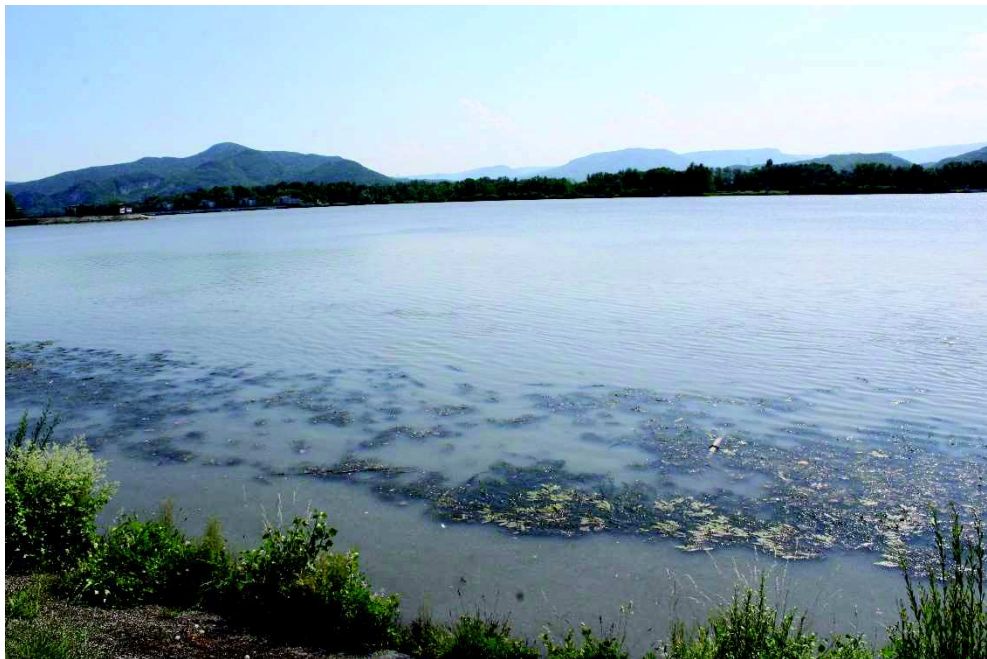
Figure 15. Vue de la retenue amont barrage de Le Pouzin (ACME, 2019)
