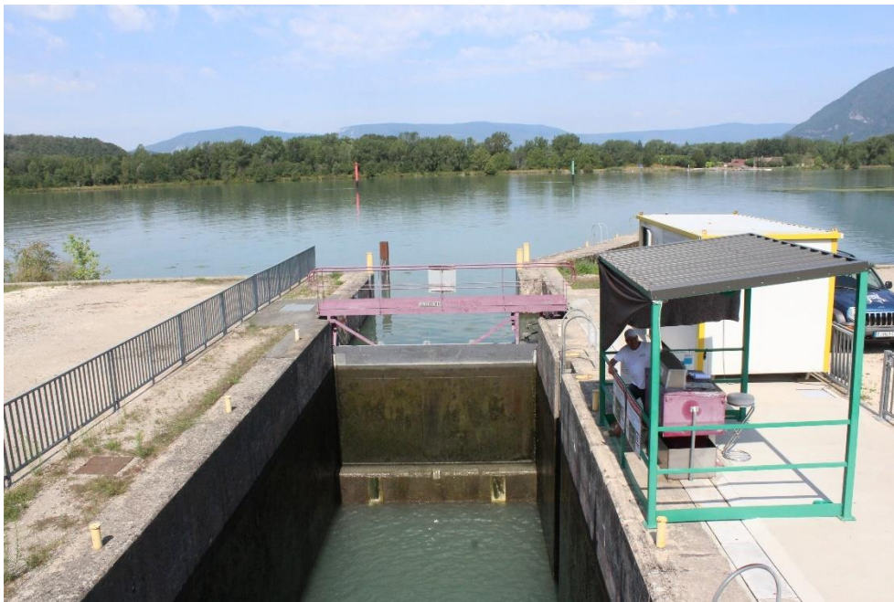
Figure 16. Accès amont de l'écluse de Savières (ACME, 2019)
