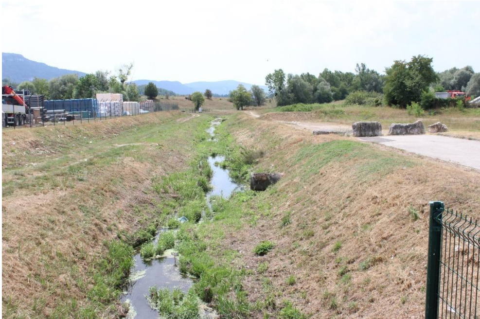
Figure 16. Cours aval de l'Ousson – Vue vers l'aval depuis le pont de Bugeymat (ACME, 2019)
