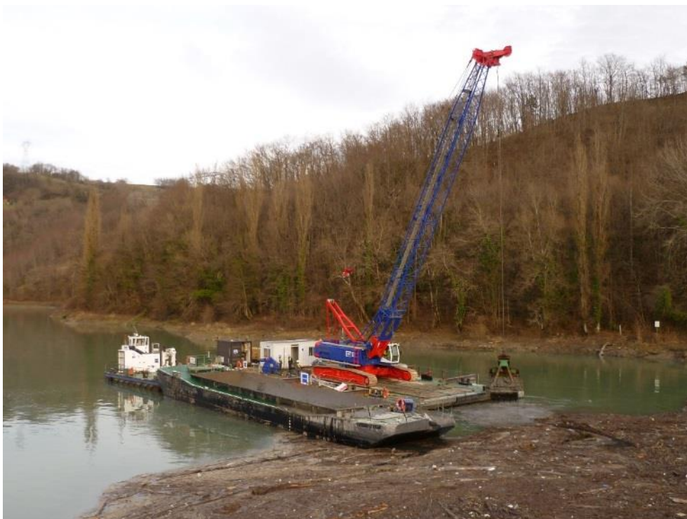
Figure 7. Pelle sur ponton avec benne preneuse sur la retenue de Génissiat (CNR, 2014)
