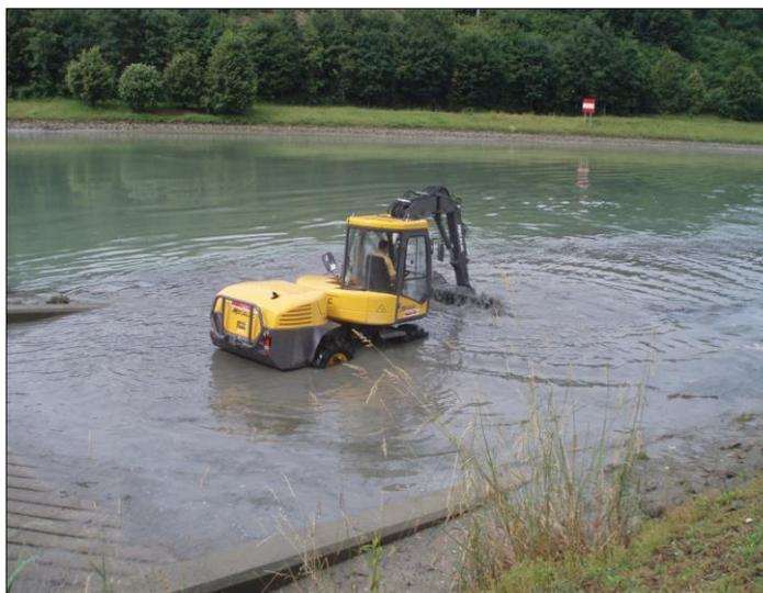
Figure 2. Exemple d'une opération de dragage d'une rampe à bateaux avec l'utilisation d'une pelle terrestre.
