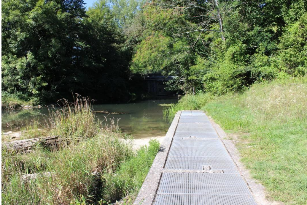
Figure 15. Vue de la passe du Furans depuis la berge entretenue – CNR 2017
