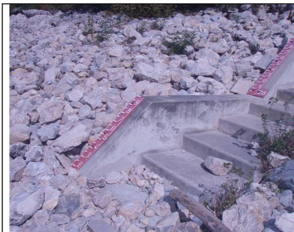
Figure 4. Echelle limnimétrique sur enrochements
