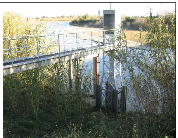
Figure 5. Echelle avec limnimètre sur structure métallique
