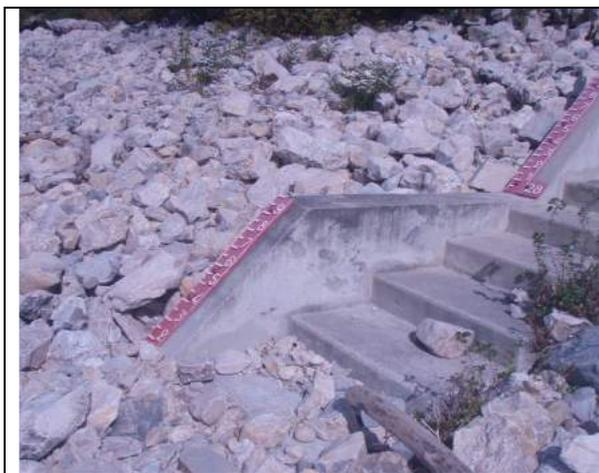
Figure 4. Echelle limnimétrique sur enrochements
