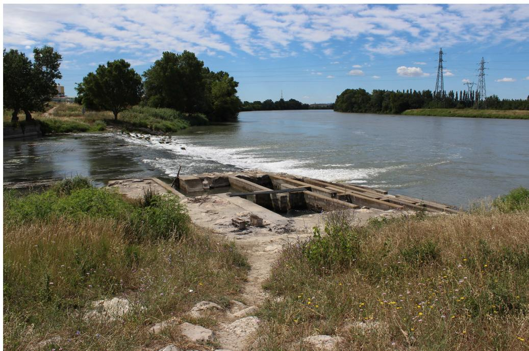
Figure 11. Vue du seuil de l'Ouvèze et de la passe à poissons (vue depuis la rive gauche du Rhône) - (ACME -2016)
