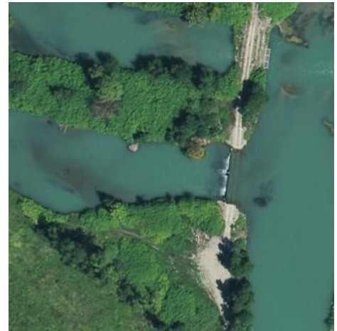
Figure 4. Passage à gué coupant l'accès au seuil des Molottes sur le Vieux-Rhône
