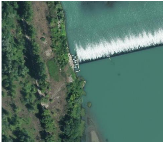
Figure 3. Accès à la passe à poissons de la rive gauche du seuil des Molottes sur le Vieux-Rhône
