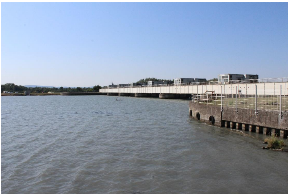
Figure 13. Vue de l'amont du barrage de Rochemaure (CNR, 2019)
