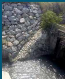
Pour permettre le passage des castors et loutres le long du Rhône, CNR aménage des rampes dont la surface rugueuse (cailloux, texture) facilite l'accroche des pattes des animaux. Ces ouvrages sont conçus en partenariat avec l'ONCFS notamment dans la réserve de Chasse et de Faune Sauvage de Donzère Mondragon.
