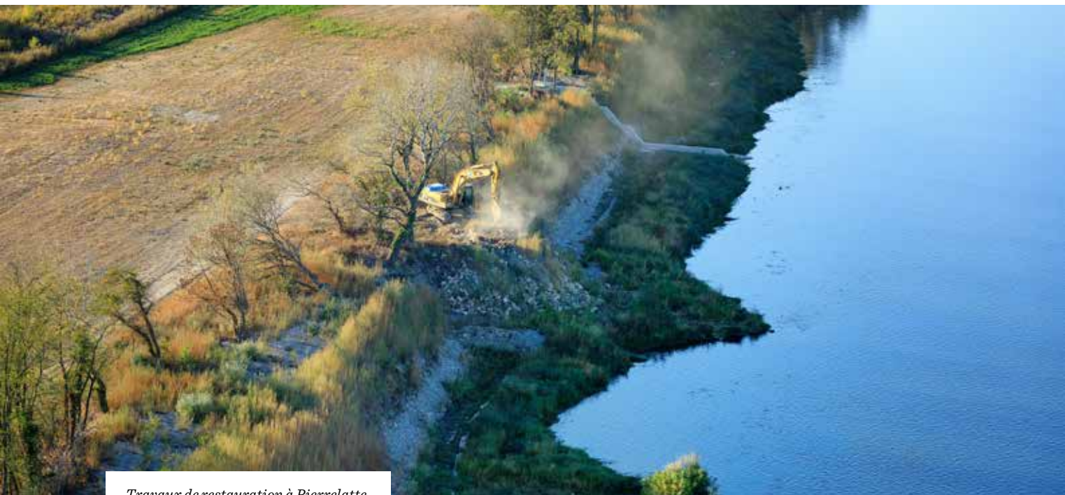
Travaux de restauration à Pierrelatte.
