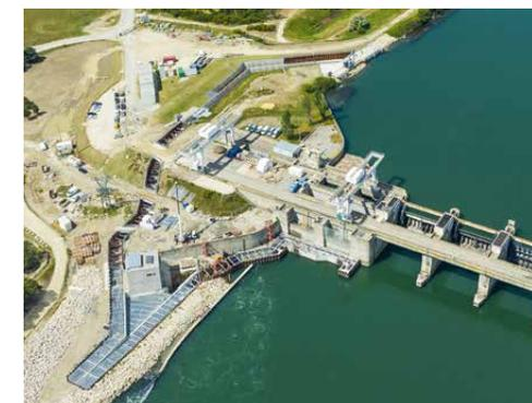
Passe à poissons sur le barrage de Sauveterre
