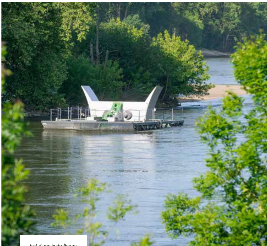
Test d'une hydrolienne fluviale sur la Loire.
