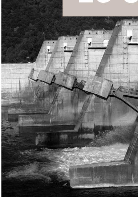
Si l'aménagement de Bourg-lès-Valence présente un principe de fonctionnement comparable à ceux précédemment réalisés par CNR (un barrage de faible retenue relève le niveau du Rhône et crée une chute sur laquelle sont installées une centrale hydroélectrique et une écluse pour le franchissement des bateaux), il offre dès sa mise en service un regain d'optimisme lié à l'impact économique potentiel apporté par ses ouvrages.
